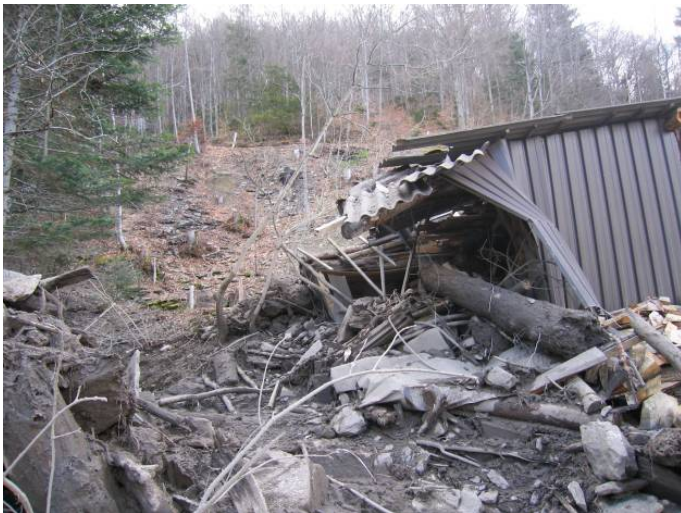
Photo 1 : Débordement solide et destruction d'un hangar
