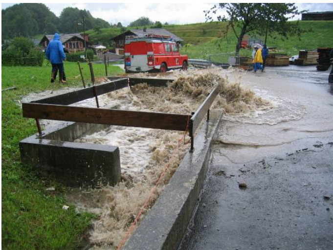
Photos 3 : Débordement liquide à la route de Véseaux (avant le changement du tuyau)
