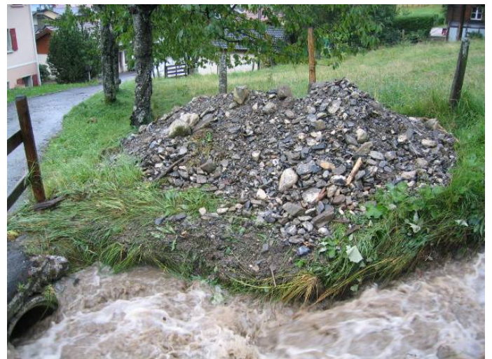
Photos 4 : Matériel ayant bouché la mise sous tuyau du chemin Vers-Chez Borré
