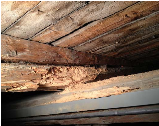
Double épaisseur des chevrons et sciure
