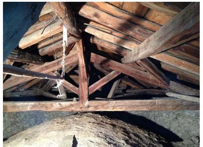
Aperçu de la charpente
